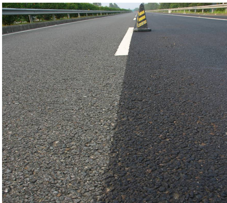
图 1-2 沥再生试验段（图中颜色较深部分）
