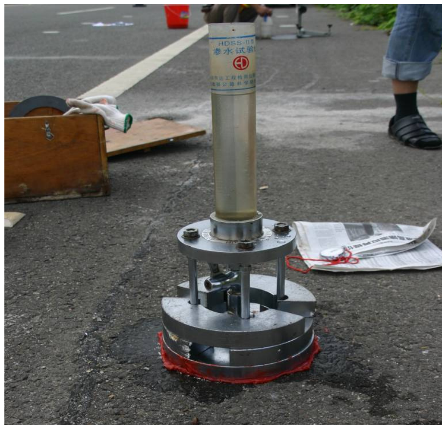
图 3-6 渗水测试现场
