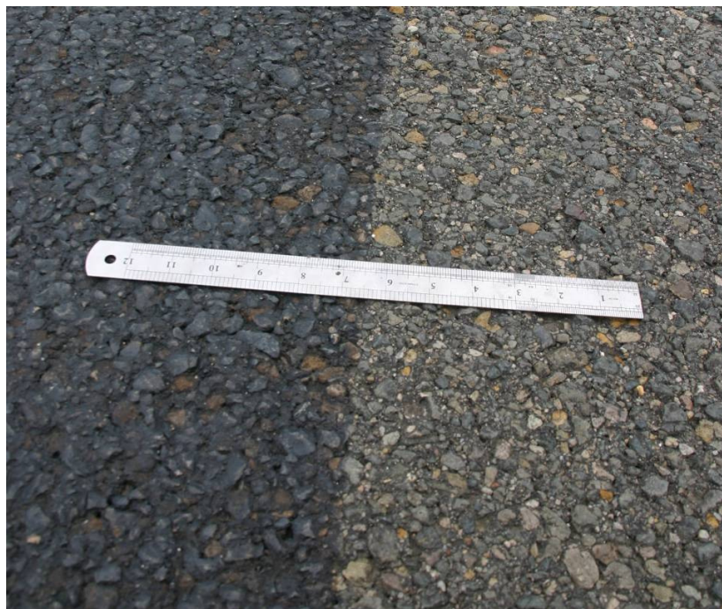
图 3-2 路面外观对比（左边为沥再生试验段）
